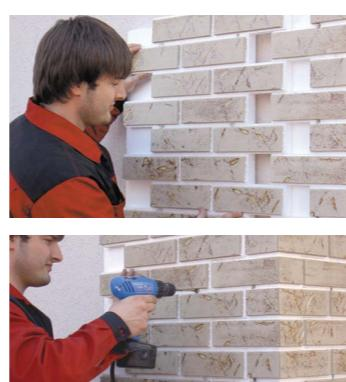
Клинкерная плитка защитно-декоративного экрана «ABC-Klinkergruppe» легко режется алмазным кругом при помощи электроинструмента, что обеспечивает архитектурную свободу оформления арочных и других элементов.
